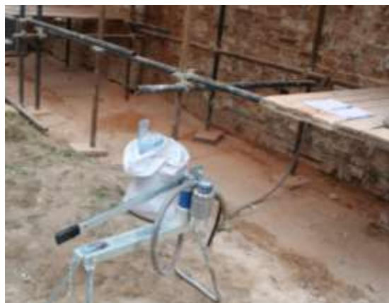
Рис. 3. Устройство отсечной гидроизоляции напорным методом
