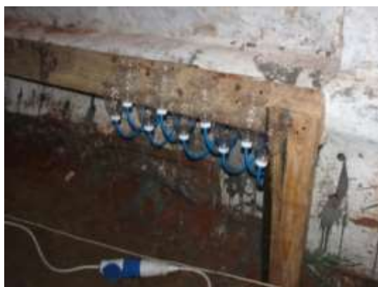
Рис. 2. Устройство отсечной гидроизоляции методом безнапорного заполнения отверстий
